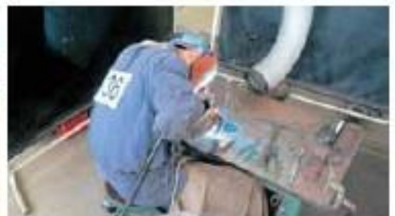
機械土木研究部 (溶接班)
